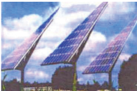
Εικόνα 4.13 Βάσεις στήριξης Φ/Β πάνελ με δύο άξονες περιστροφής
