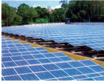
Εικόνα 4.10 Τοποθέτηση Φ/Β συλλεκτών με χειροκίνητη ρύθμιση της κλίσης πάνω στο έδαφος.
