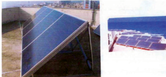
Εικόνα 4.9 Τοποθέτηση Φ/Β συλλεκτών με χειροκίνητη ρύθμιση της κλίσης πάνω σε όροφο (δώματα) κτιρίων.
