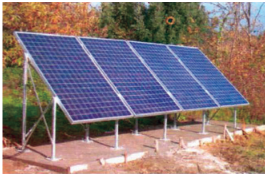
Εικόνα 4.10 Τοποθέτηση Φ/Β συλλεκτών με χειροκίνητη ρύθμιση της κλίσης πάνω στο έδαφος.
