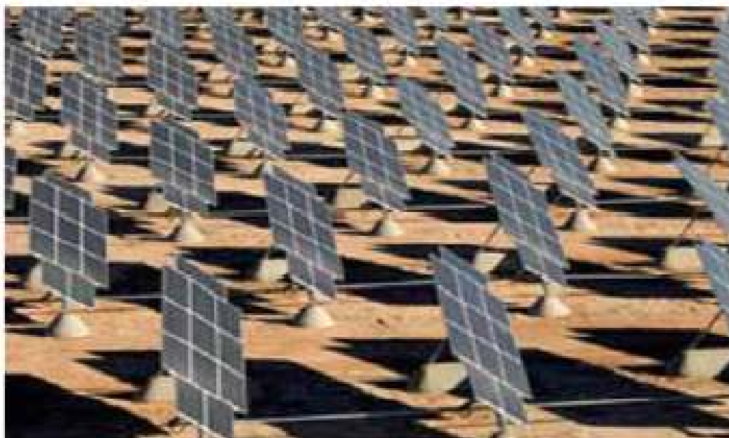
Σχήμα 30: Διατάξεις ιχνηλάτησης της πορείας του ήλιου μονού άξονα
