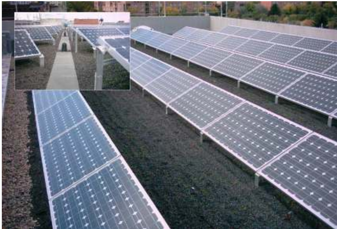
Παράδειγμα τοποθέτησης βάσεων επί στέγης
