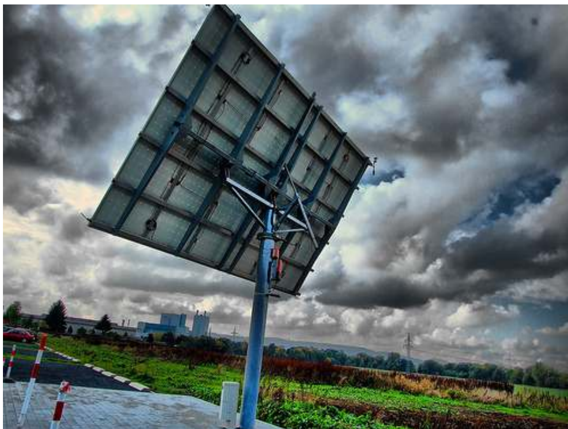
Σχήμα 31: Διατάξεις ιχνηλάτησης της πορείας του ήλιου διπλού άξονα
